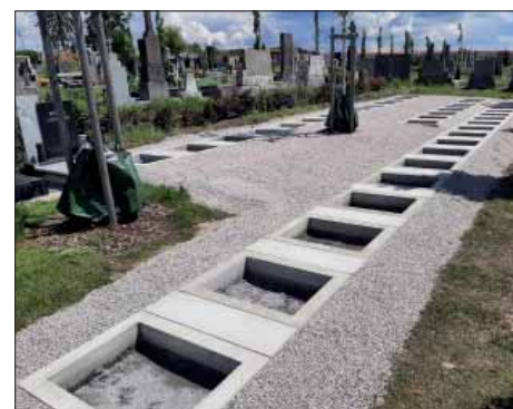
Nová místa s předinstalovaným betonovým rámem k urnovým hrobům
