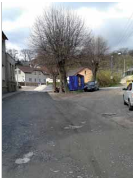
Malostranské náměstí - stav před rekonstrukcí
