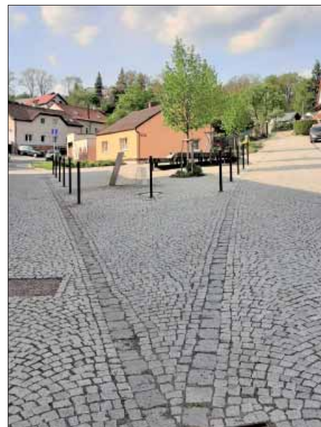
Malostranské náměstí - stav po rekonstrukci
