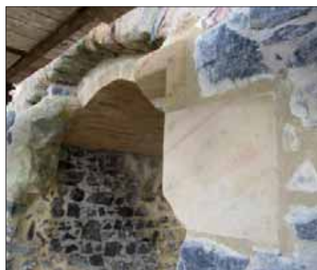
Jedno z opravených palácových oken hradu Radyně Foto: Václav Vajshajtl
