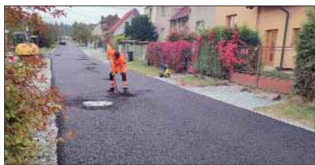
Podzemní stavba komunikace v Havlenově ulici ve St. Plzeňci
