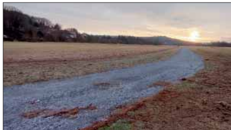
Stavba cyklostezky Starý Plzeňec – Sedlec
