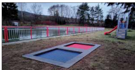
Nově vybudované trampolíny u víceúčelové nádrže ve St. Plzeňci
