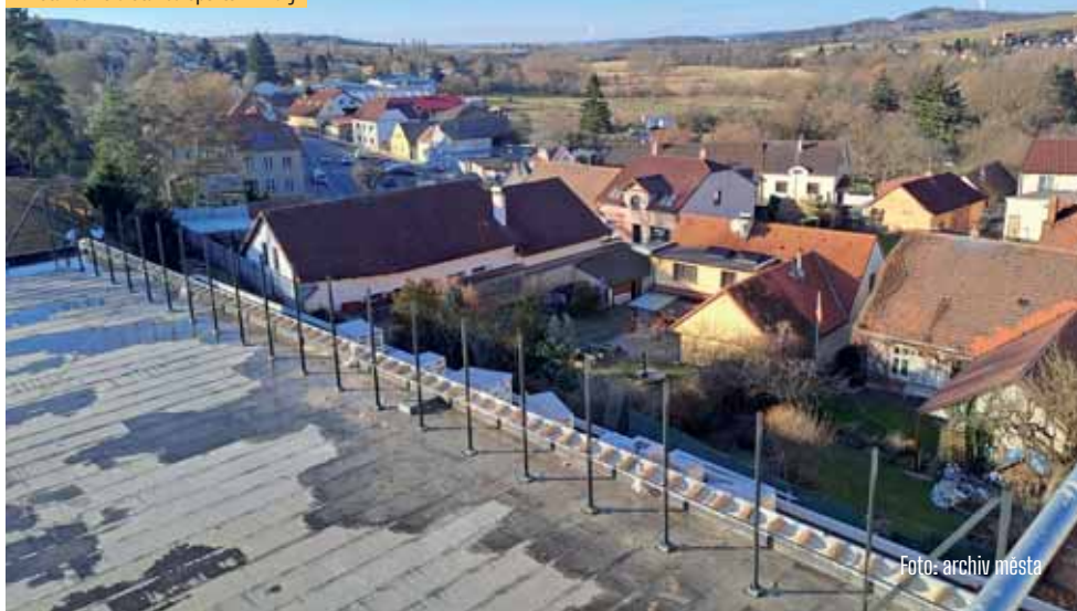
Přístavba ZŠ a stavba sportovní haly
