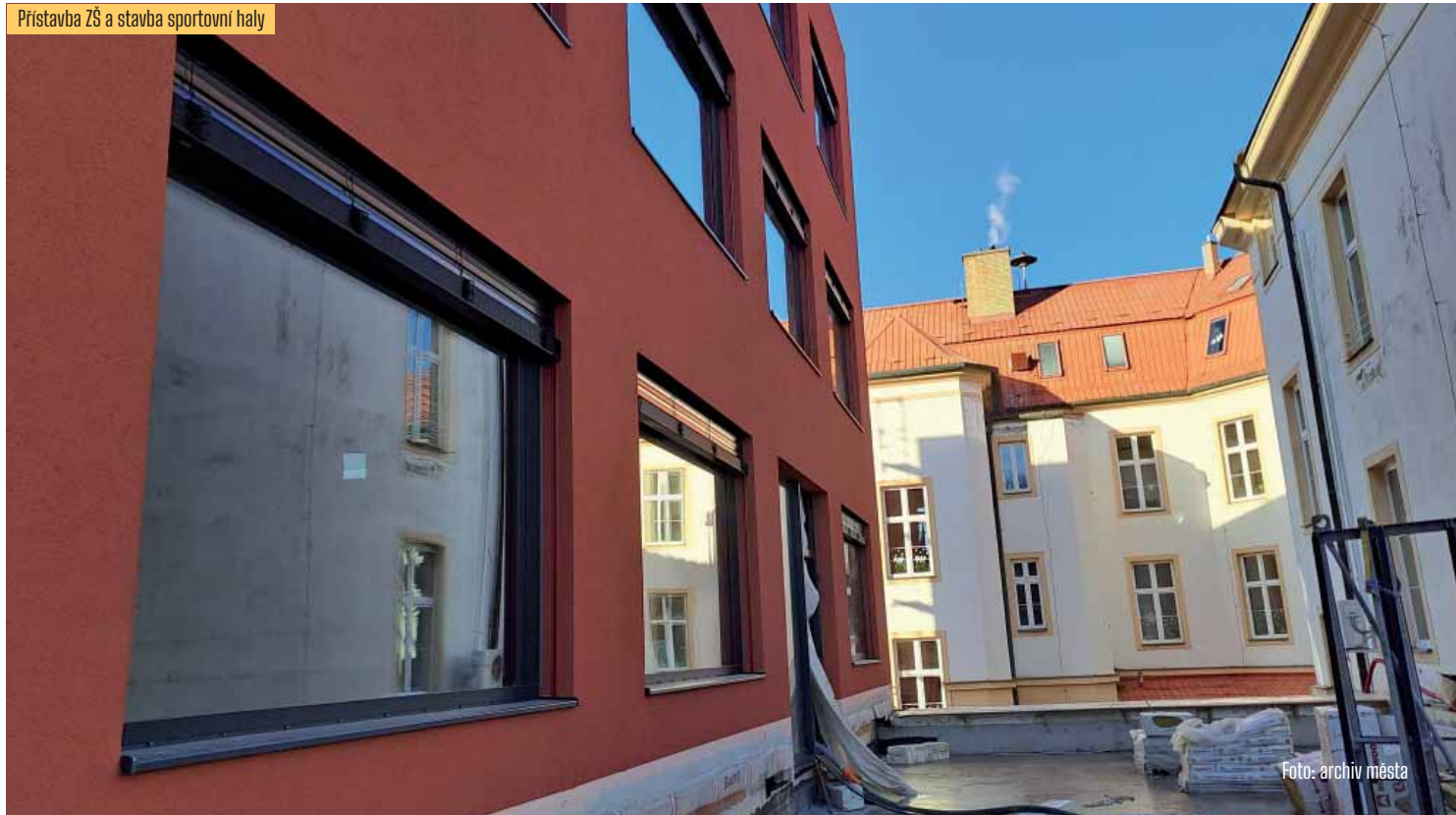
Přístavba ZŠ a stavba sportovní haly
