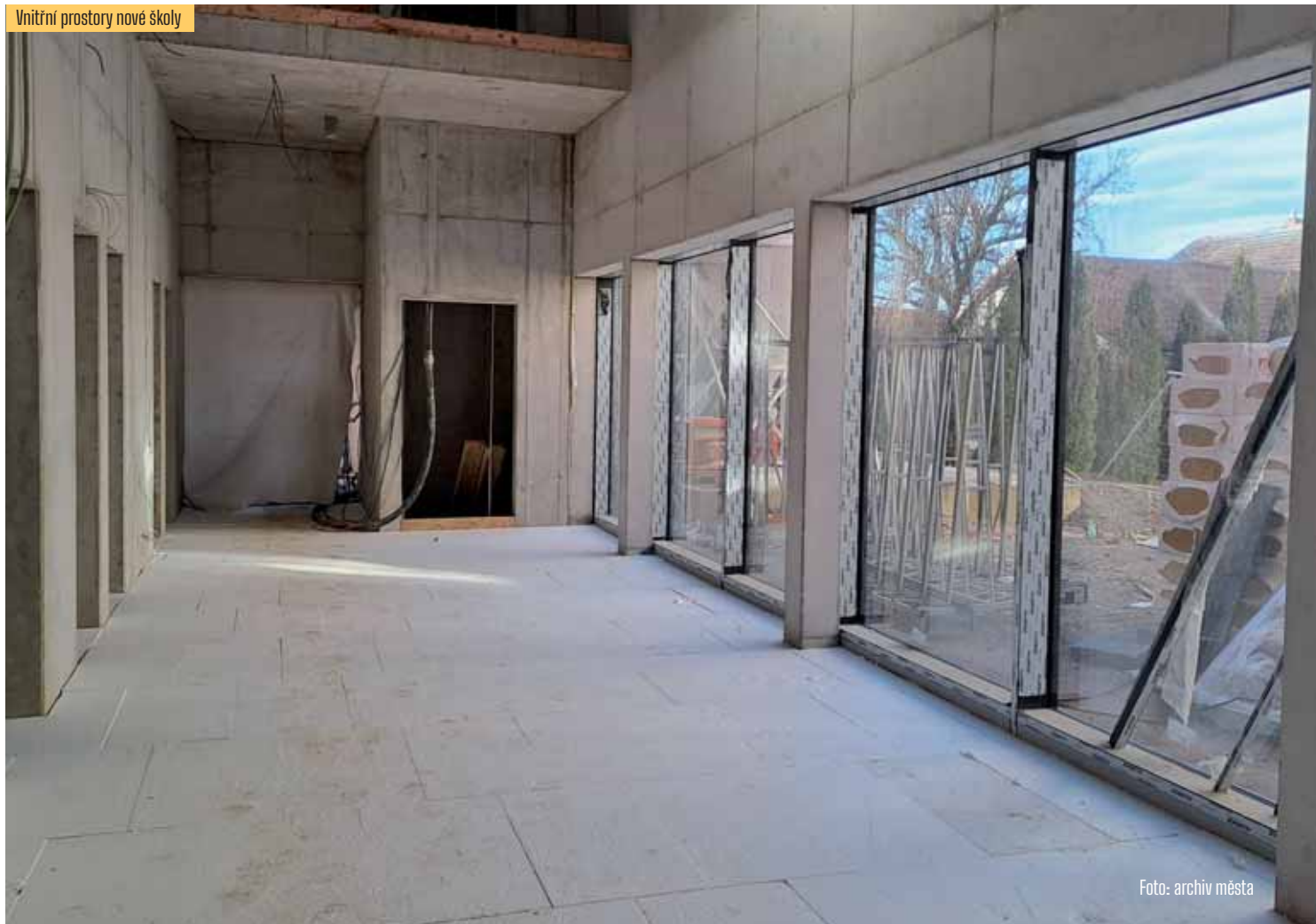
Vnitřní prostory nové školy
