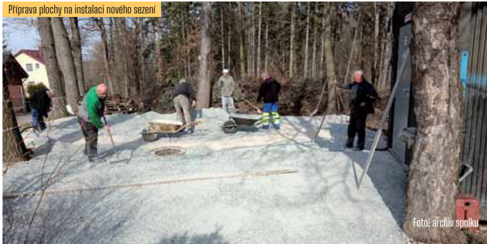
Příprava plochy na instalaci nového sezení
