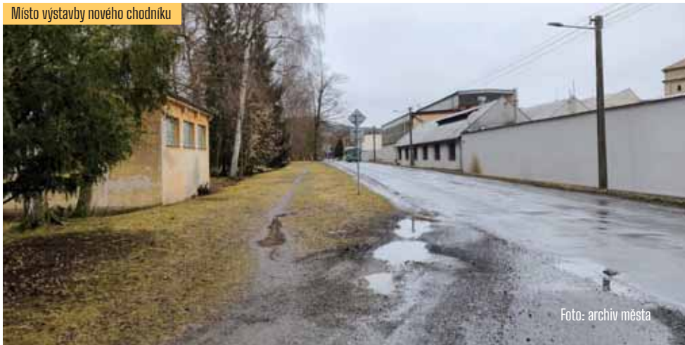
Místo výstavby nového chodníku
