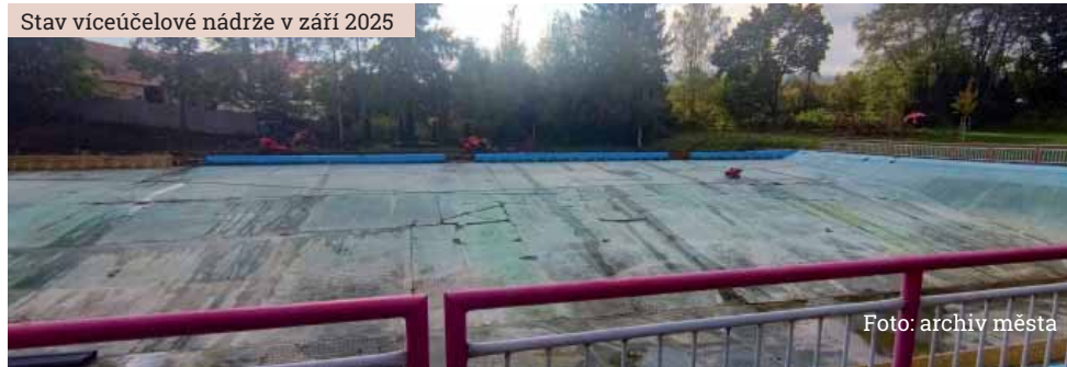
Stav víceúčelové nádrže v září 2025
