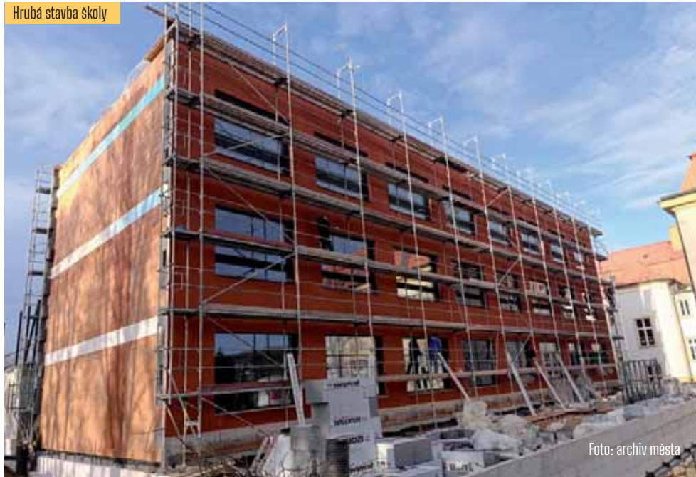
Hrubá stavba školy
