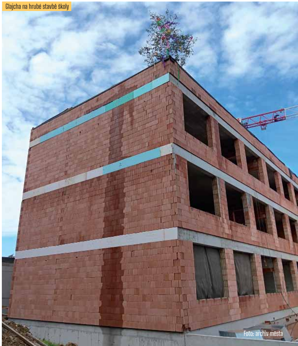
Glajcha na hrubé stavbě školy
