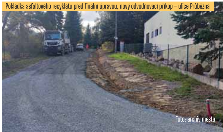
Pokládka asfaltového recyklátu před finální úpravou, nový odvodňovací příkop – ulice Průběžná
