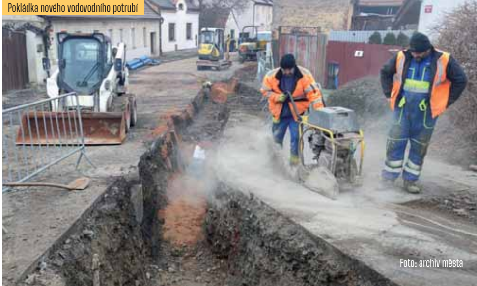
Pokládka nového vodovodního potrubí
