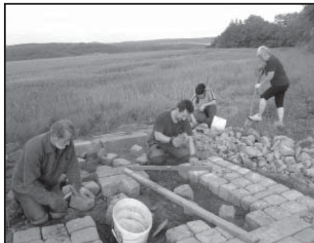
Práce na základu pro krytou lavičku a sběr kamene. Foto: archiv OSHR
