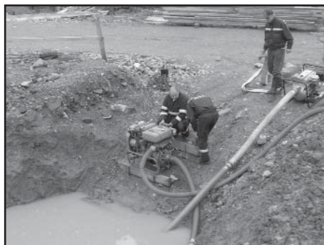
Odčerpávání vody z areálu stavby ČOV Foto: Luboš Lenc, Soňa Šmejkalová
