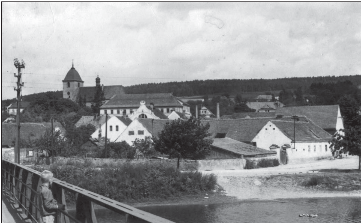
Železný most přes řeku Úslavu
