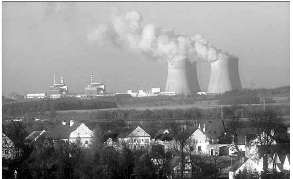
Jaderná elektrárna Temelín.
