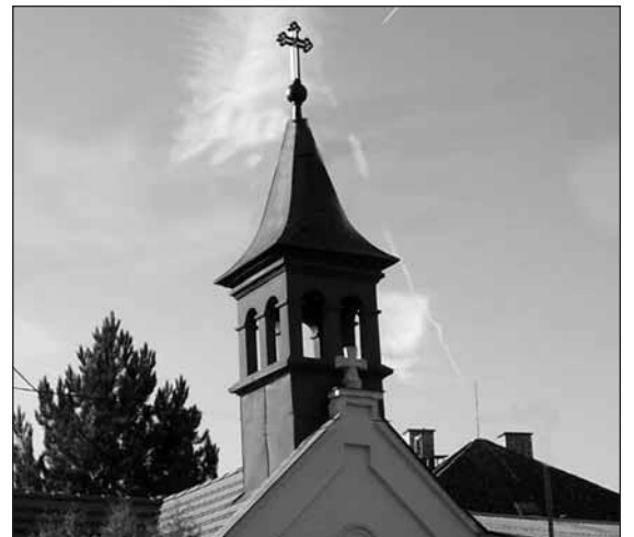
Věž kapličky v Sedlci s opraveným křížem.
