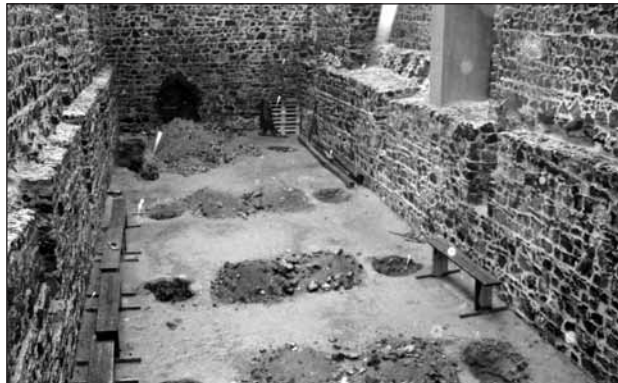
Odvodňovací práce uvnitř hradu Radyně (pozn. foto pořízeno za hustého deště).
