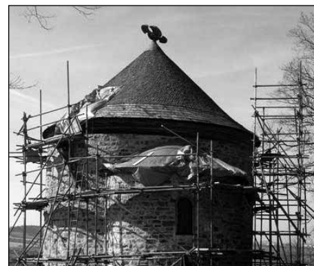
Na opravě střechy rotundy se pilně pracuje i za nepříznivého počasí. Foto Eva Vlachová
