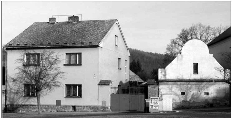
Současný vzhled domu č.p. 71.
