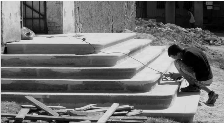
Poslední úprava schodiště u hlavního vstupu do kostela Narození P. Marie.
