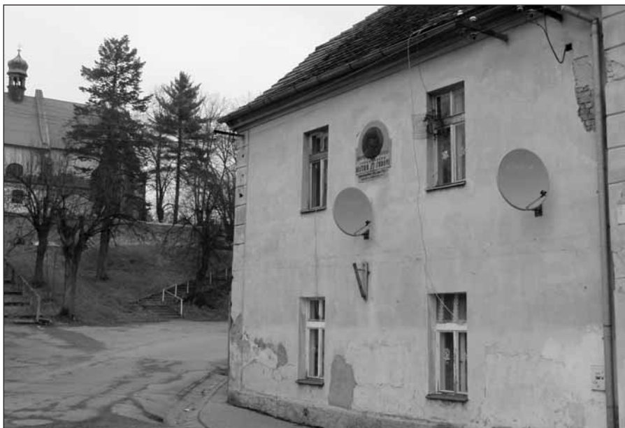
Celkový pohled na dům, kde se nachází pamětní deska hudebnímu skladateli Stanislavu Sudoví. Foto Eva Vlachová
