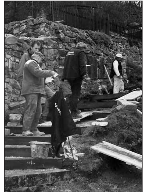
Práce na obnově přístupové cesty na Hůrku.
