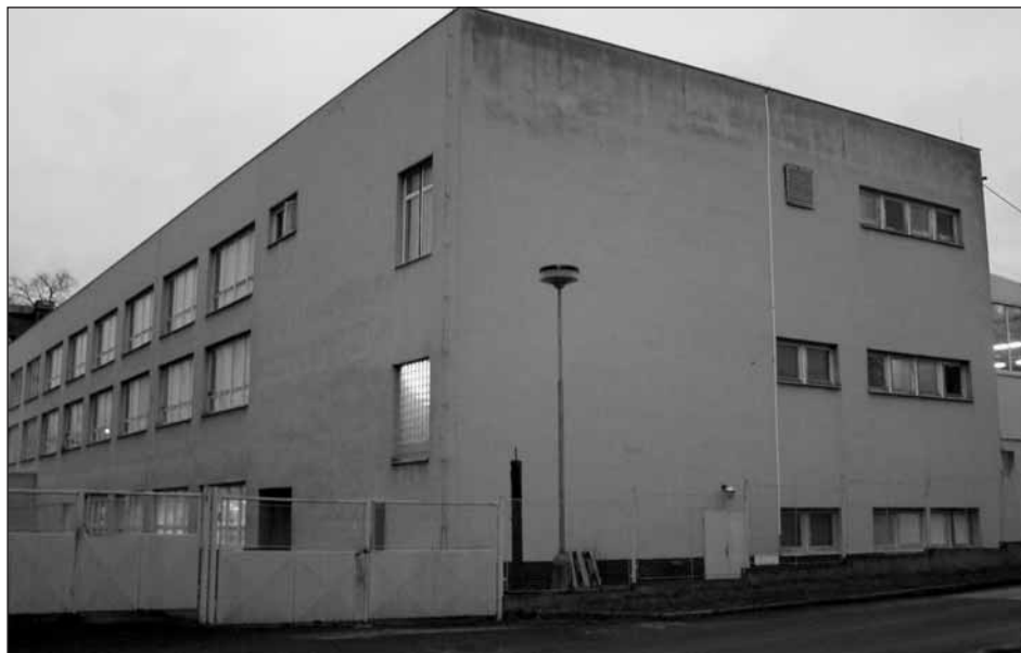
Na místě bývalého domu č. p. 218, o jehož historii je článek, stojí dnes hlavní výrobní budova společnosti Propap.
