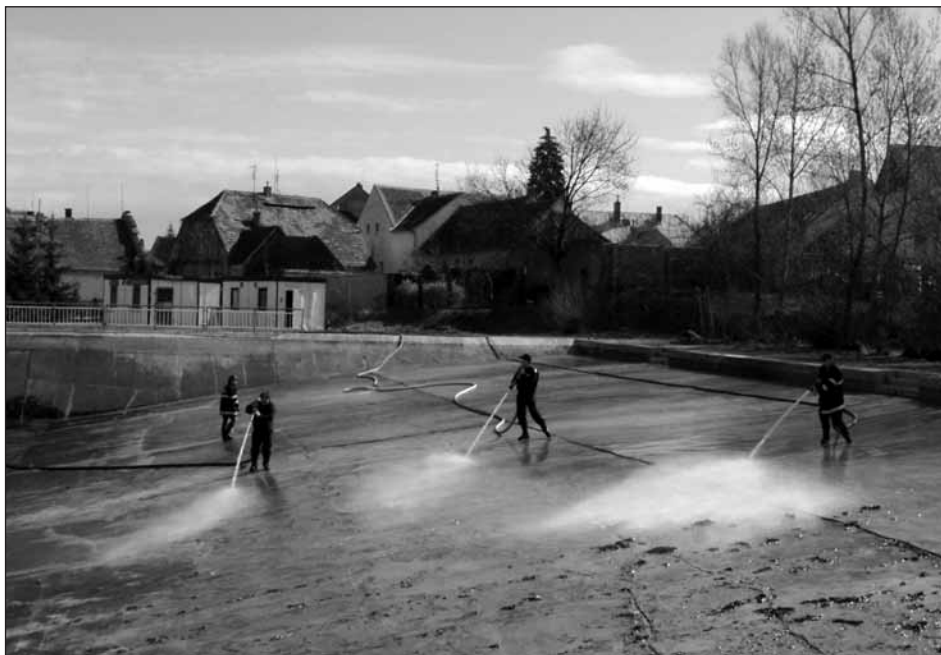
Čištění víceúčelové nádrže ve Starém Plzenci před začátkem sezóny.
